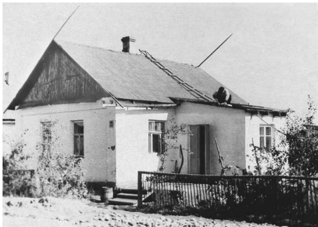
Дом в переулке Олега Кошевого. На крыше отец занят мелким ремонтом. 1957 г.
